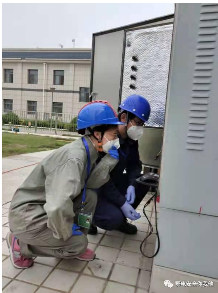
图 3 油色谱在线监测装置现场校准
